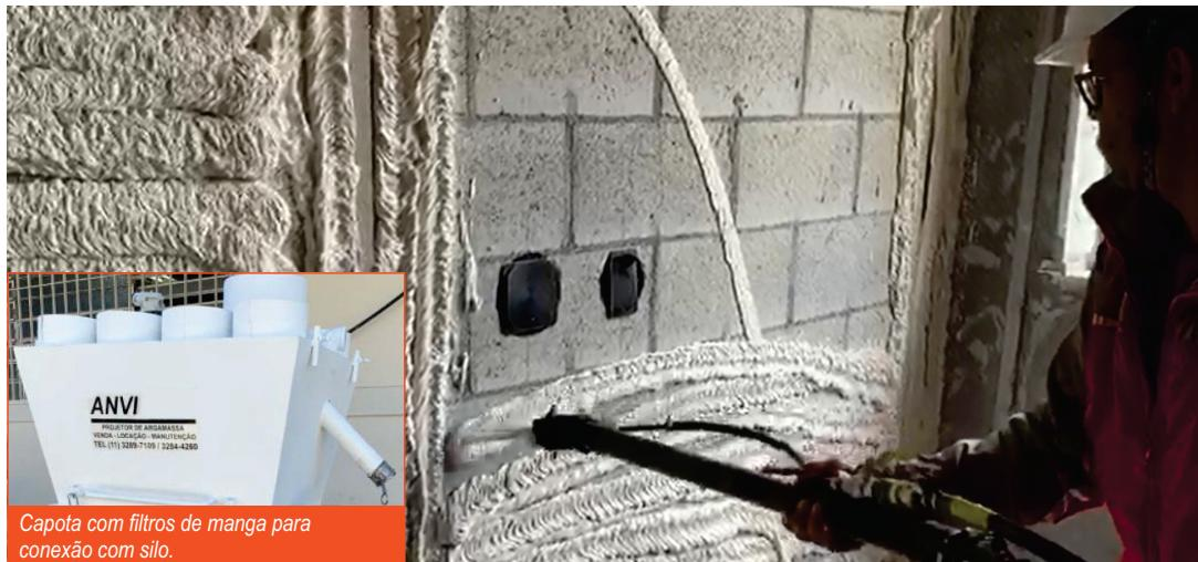
A DUOJET faz a mistura, transporte e projeção de argamassa ou gesso especial para projeção. A bomba d'água já vem acoplada na máquina, fácil de regular e usar. Além de acelerar o prazo de execução do revestimento traz, economia de mão de obra na projeção e no transporte da argamassa.
